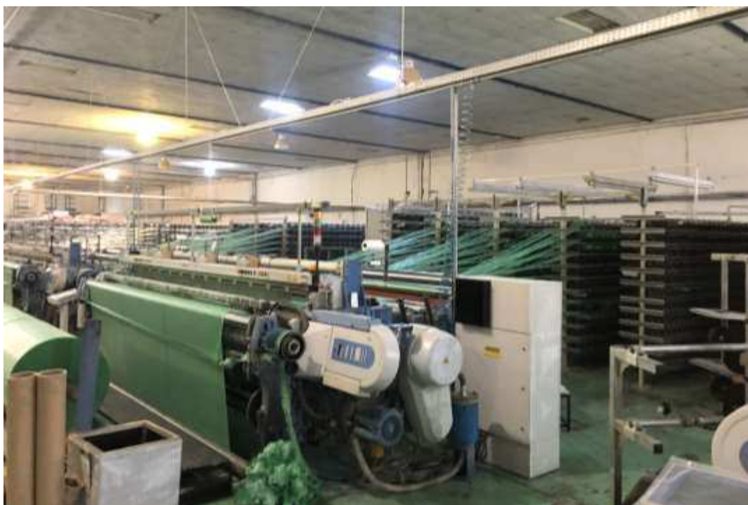
Foto 012: Maquinário operando normalmente
