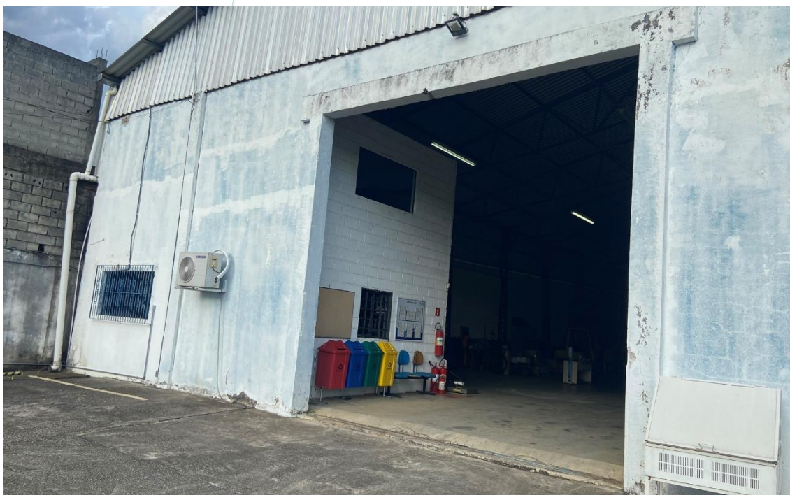
Foto 002: Entrada para às dependências internas do galpão
