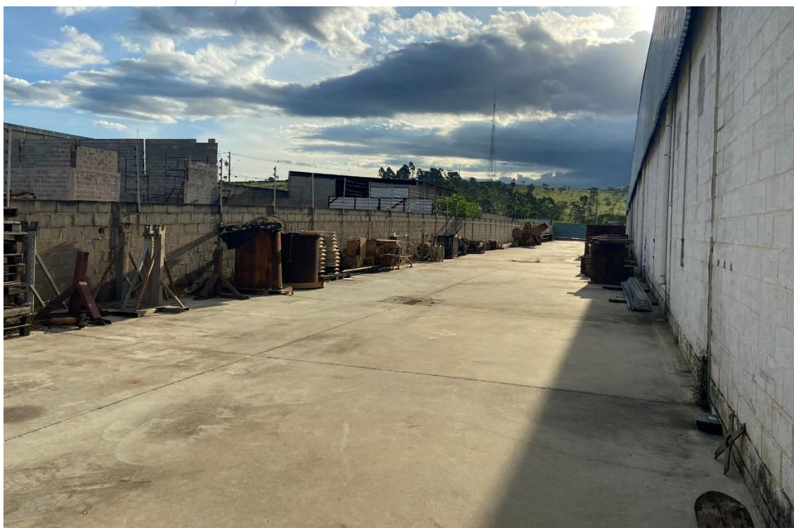
Foto 018: Vista externa do galpão
