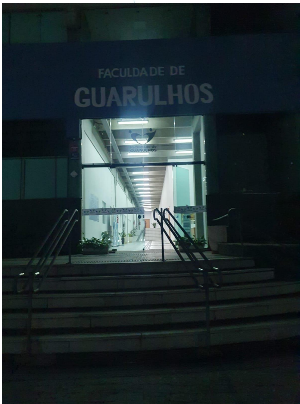
Foto 003: Acesso as dependências da faculdade
