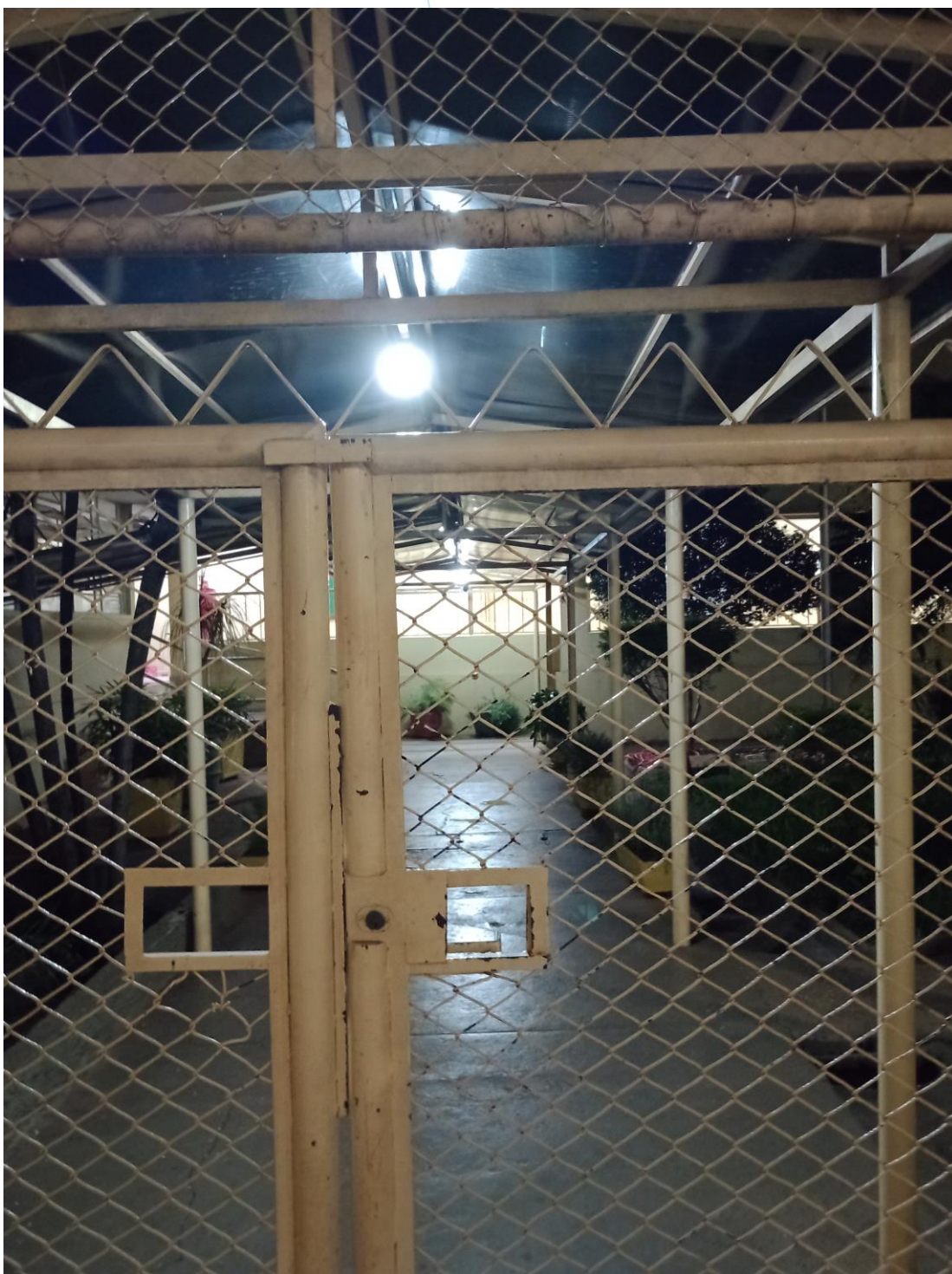
Foto 002: Portão de entrada da faculdade 2
