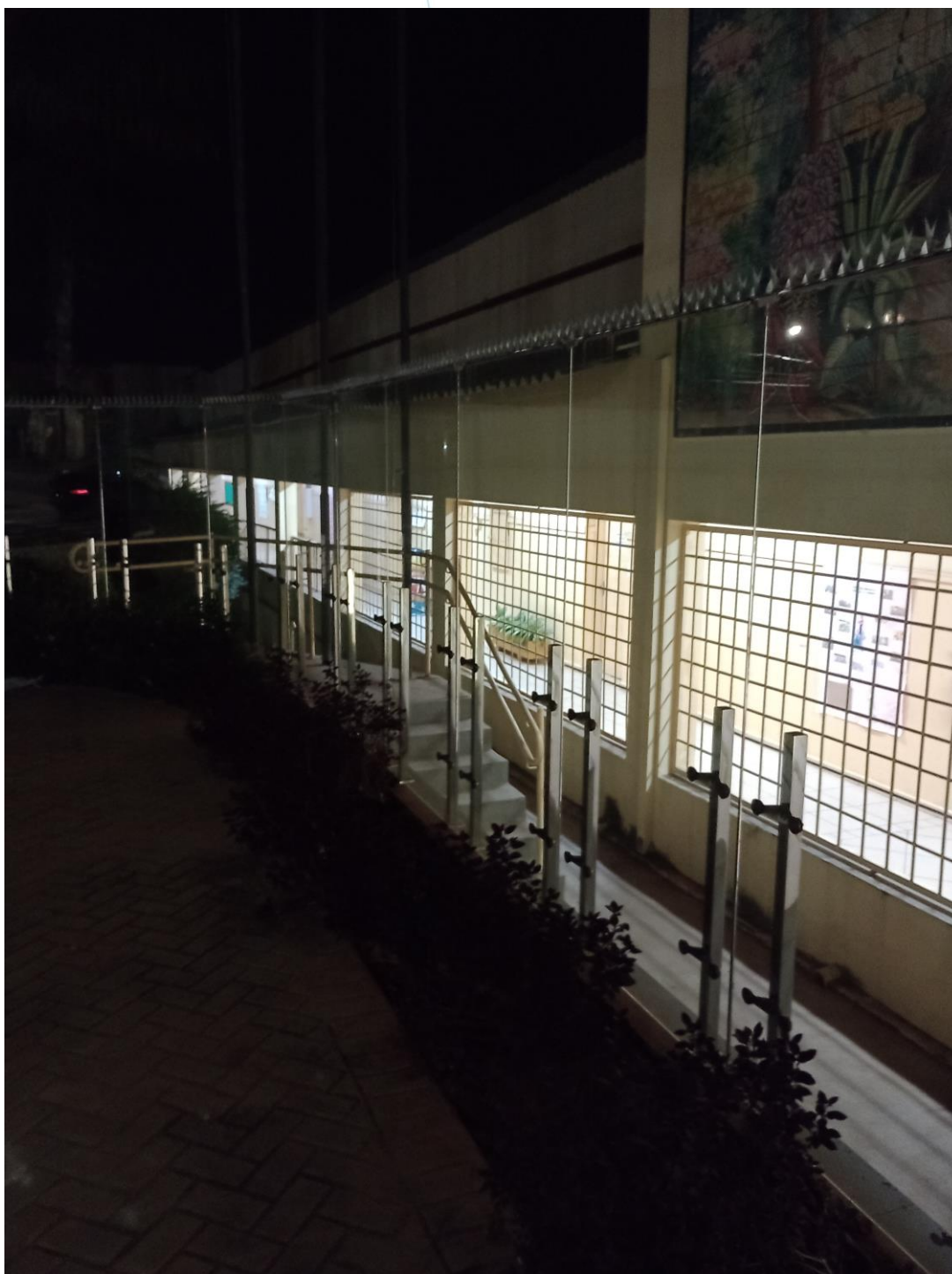
Foto 003: Acesso às dependências internas da faculdade
