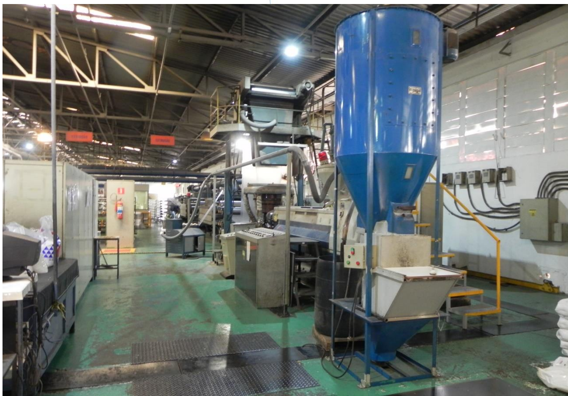
Foto 013: Equipamento em ótimo estado de conservação
