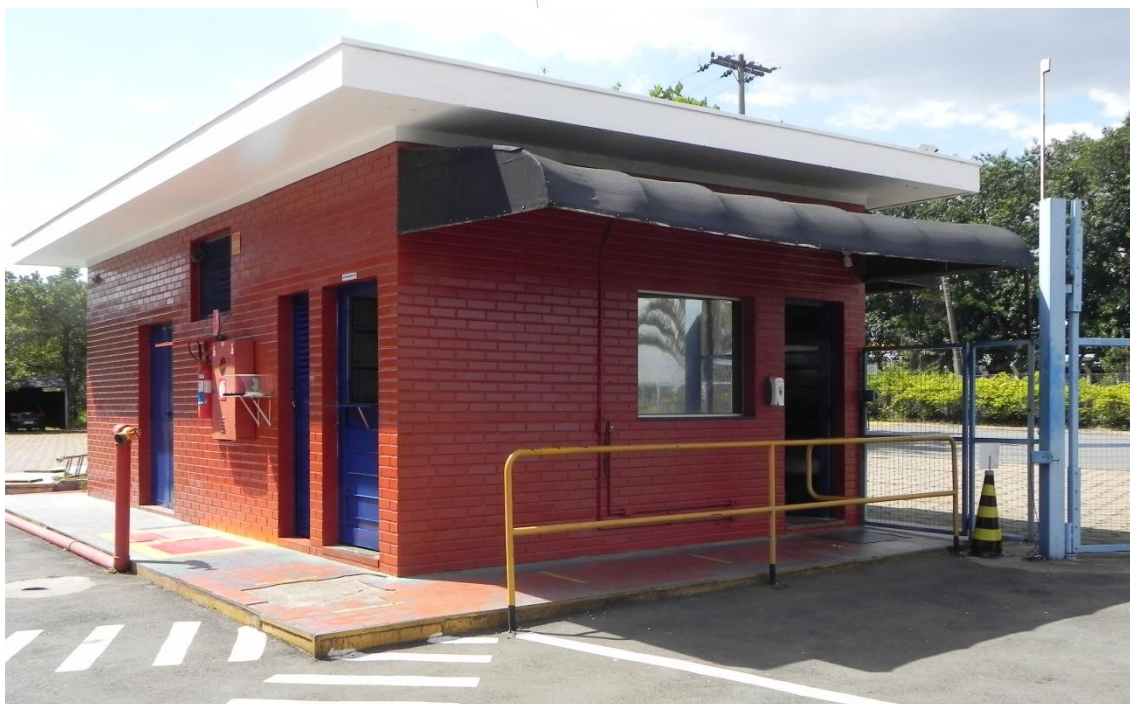
Foto 001: Entrada principal e portaria
