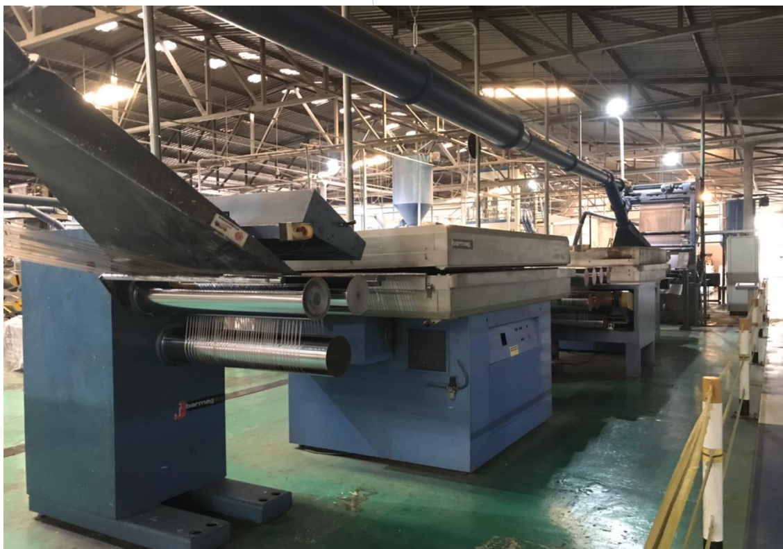
Foto 011: Máquina em perfeito estado de conservação
