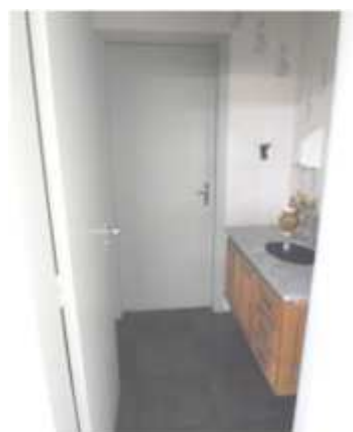
Banheiro no pavimento superior
