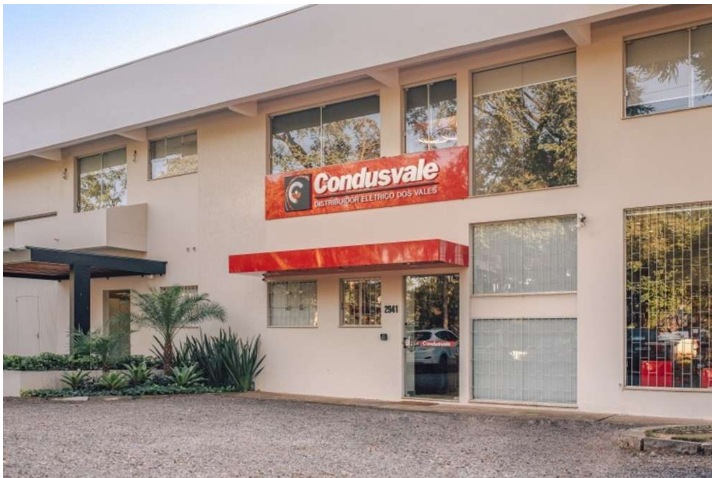
Figura 2: Sede administrativa da RECUPERANDA
