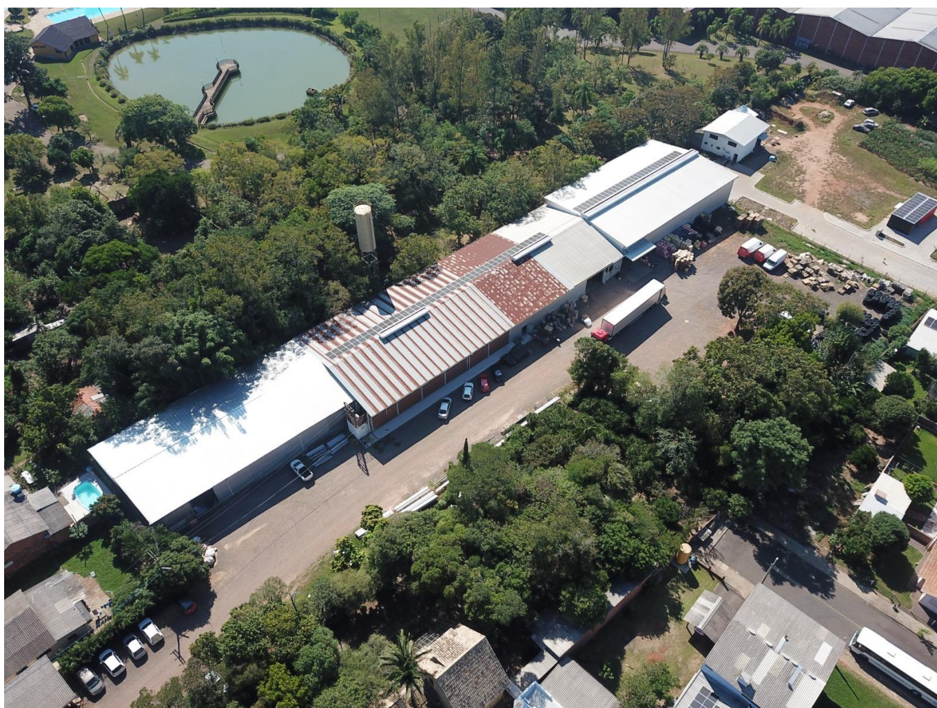
Figura 1: Centro logístico da RECUPERANDA
