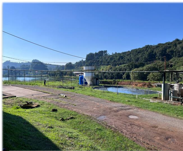
Estação de tratamento de efluentes
