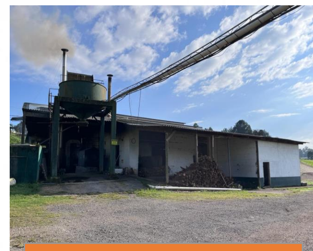
Prédio das caldeiras
